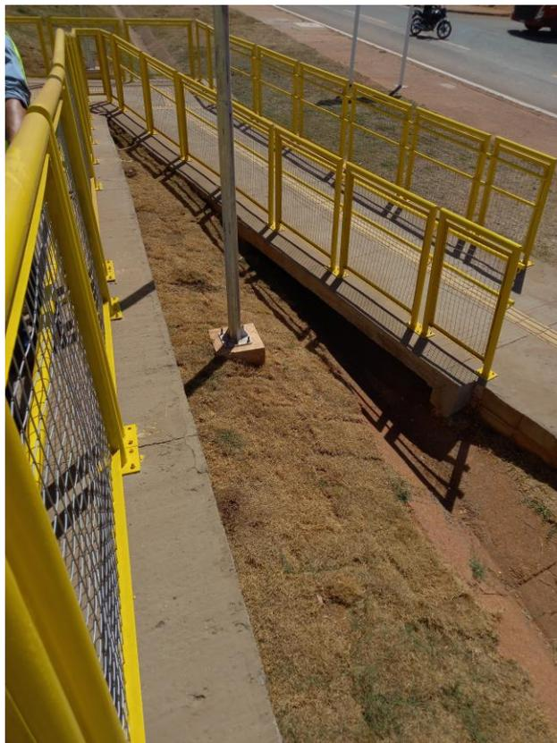
*Figura 18 Transposição da sarjeta de canteiro no acesso a rampa da passarela.*
