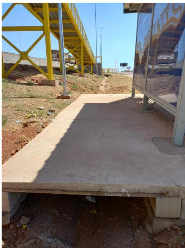
*Figura 19 Transposição da sarjeta de canteiro ao lado do abrigo do ponto de ônibus.*
