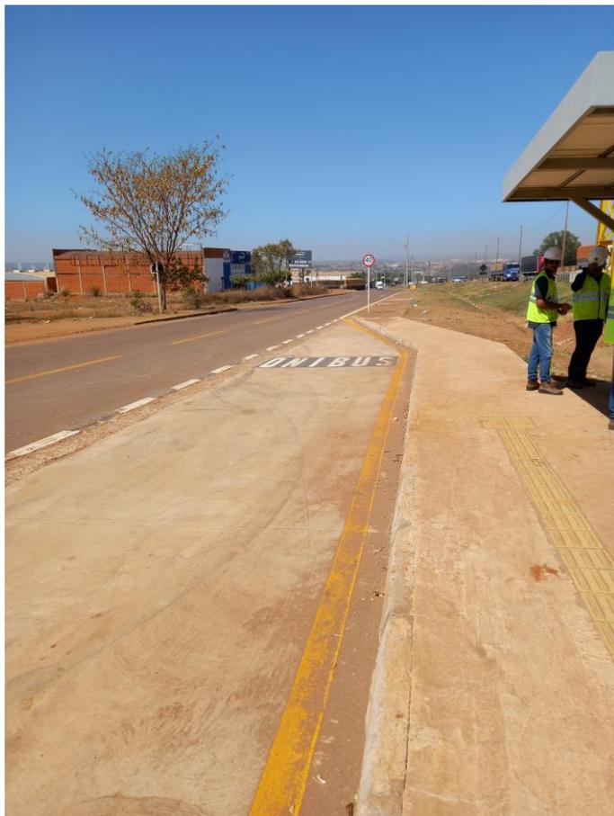
*Figura 24 Pavimento em concreto armado executado*
