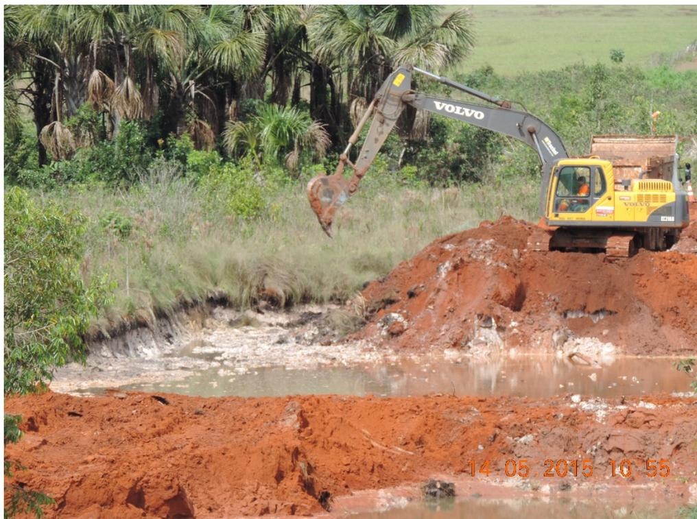
Foto 02 – Remoção de solos compressíveis – Margem norte do Rio Cachoeira
