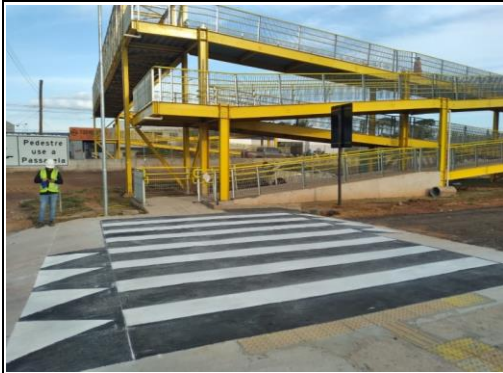
Localização Descrição BR 163/MT KM 839+800 - Sinop Elementos pré-fabricados
