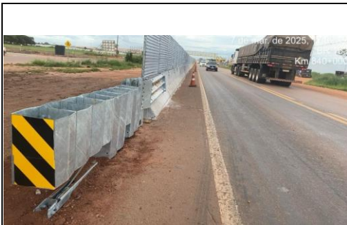
Localização Descrição BR 163/MT KM 839+800 - Sinop Implantação de Barreira rígida e tela antiofuscante.
